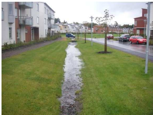
Bild 4: Öppet mackadammdike i bostadsområde. (P105 Hållbar dag- och dränvattenhantering)
